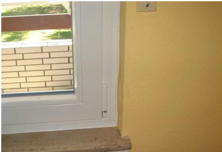
Abb. 2: Fugenanschluss nach der Sanierung
